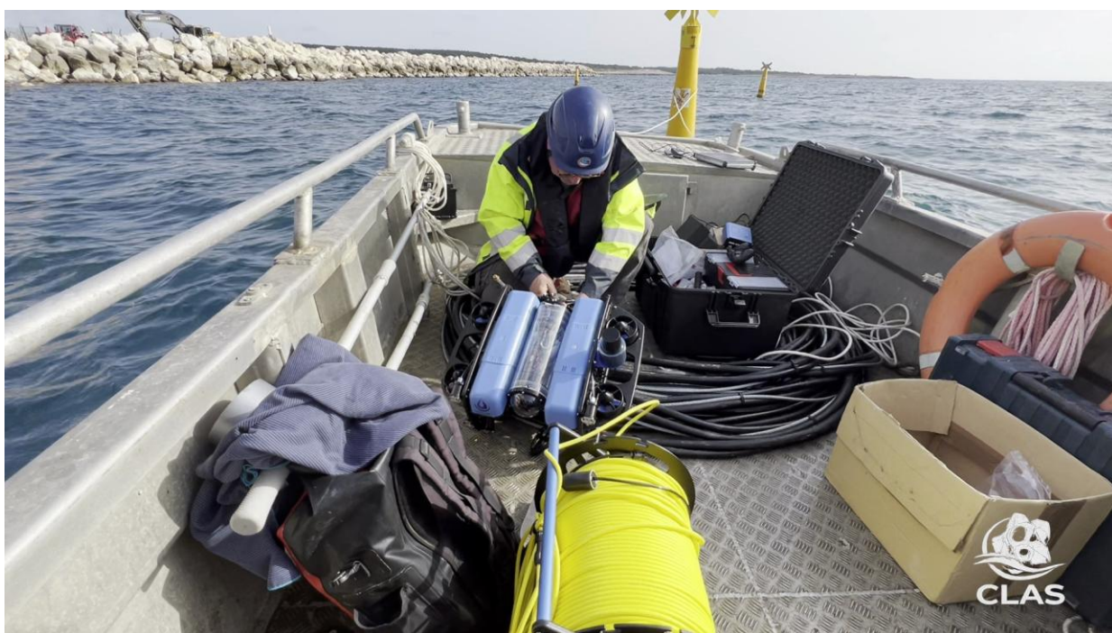
L'inspecteur CLAS prépare le ROV pour l'inspection des prises d'aspiration d'eau de mer de la centrale EDF de Martigues.
